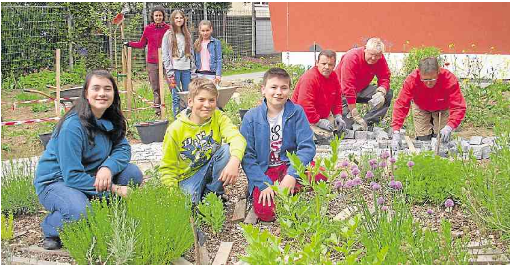
Mit Sack und Pack ging es an die Arbeit im Emanuel-Felke-Gymnasium. Mit der Firma Fliesen Fadel aus Idar-Oberstein wurde ein Pflasterweg durch den neuen Schulgarten gelegt.
