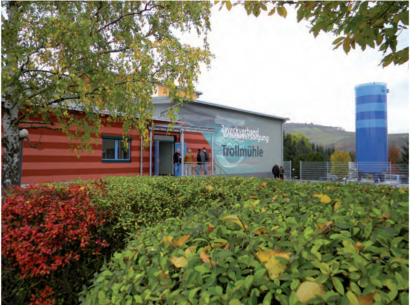
Das Gebäude der Uranentfernungsanlage passt sich perfekt in die Landschaft ein Foto: Peter Zoernack
