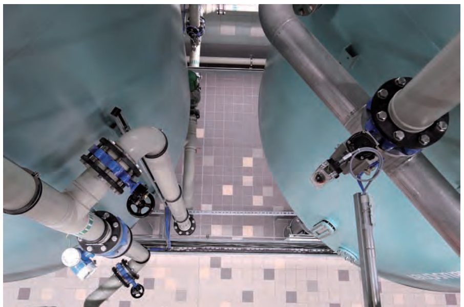
Behälter und Wände wurden entsprechend des Farbkonzepts aus einem Farbgruss hergestellt, Foto: Fliesen Fadel GmbH & Co. KG
