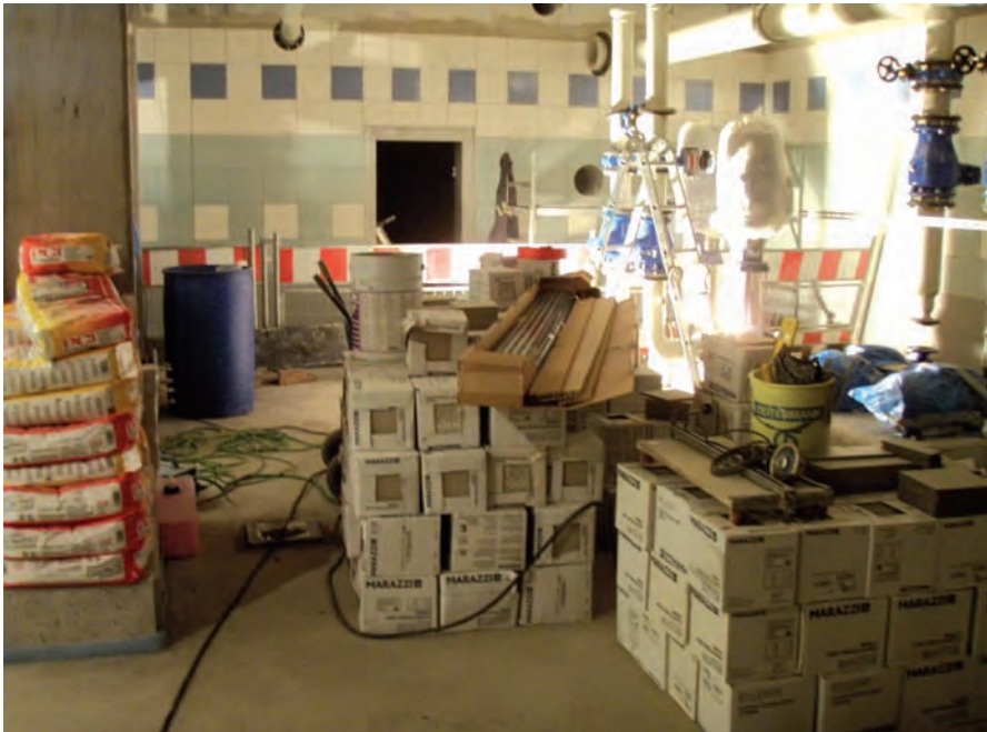
280 m 2 Wandfliesen und 575 m 2 Bodenfliesen wurden in Windesheim verlegt, Foto: Fliesen Fadel GmbH & Co. KG
